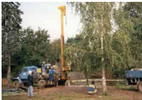
■ Foto: Geotermální vrt u ZŠ
