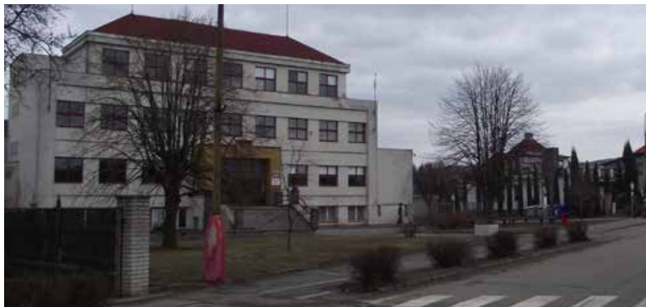
■ Foto: Vchod do základní školy
