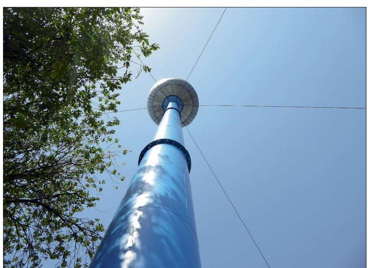
V měsíci červenci proběhla kompletní rekonstrukce vodojemu v Nesvačilech, která spočívala ve vnitřních i vnějších nátěrech, uvedení vodojemu do svislé podoby a provedení hygienických zkoušek.
