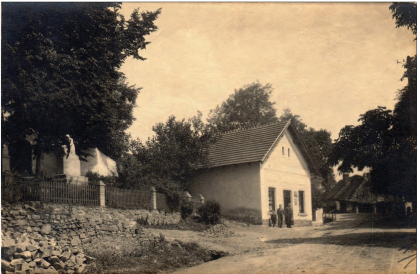
Na řadě jsou Nesvačily. Tento pohled je pro většinu z nás neznámý.
