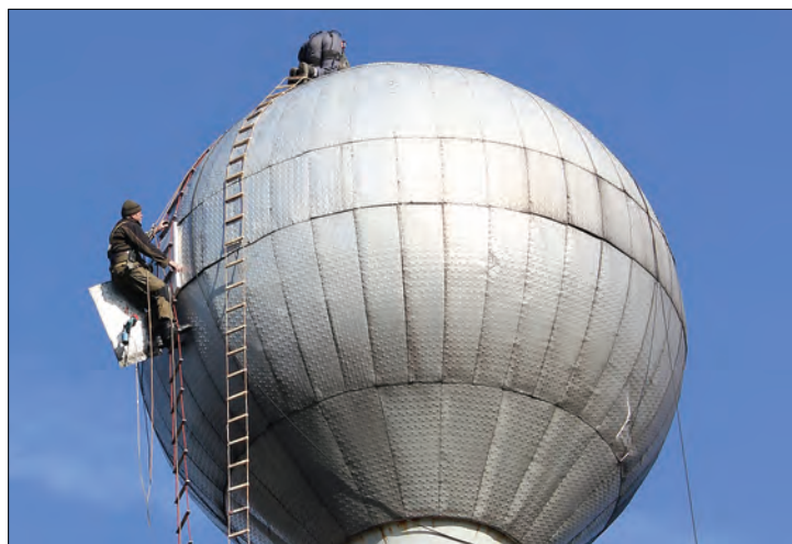
V Nesvačilech bylo třeba opravit plášť vodojemu, jehož opláštění bylo poškozené prudkým větrem.
