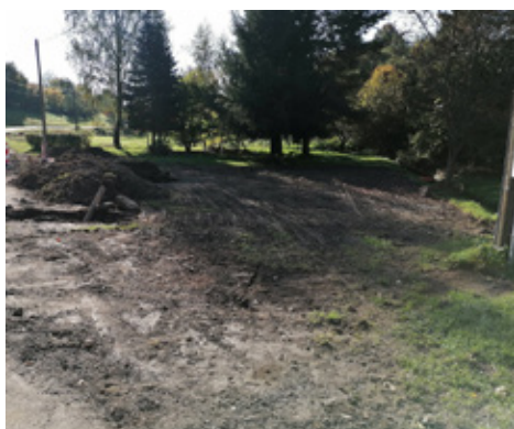
■ Návěs v Zahofanech během stavby.
