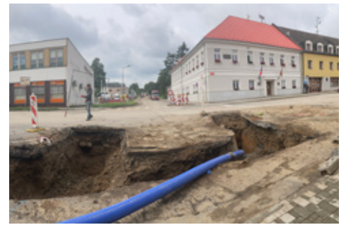
■ Na náměstí probíhala pokládka nové přiváděče vody.
