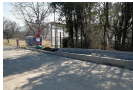
■ Vzniká nová čekárna autobusové zastávky a nové chodníky v Nesvačilech.
