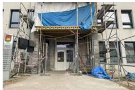
■ Pokračuje stavba bezbariérového přístupu do 2NP budovy zdravotního střediska v ulici Syllabova 450.
