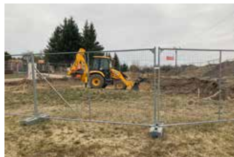
■ Práce na Spolkovém domě v Líšně byly zahájeny.
