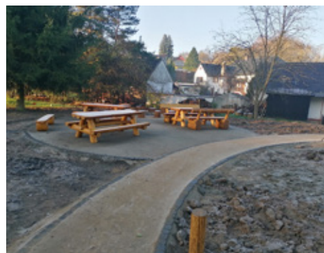
■ Vítězný projekt roku 2022: Revitalizace návsi v Zahořanech
