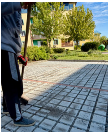
■ Polovegetační dlažba, skrze kterou prostupuje voda do půdy
