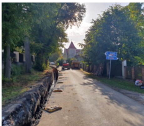
■ Fotografie z roku 2023: Pokládka vodovodu v Líšně – V Lipách
