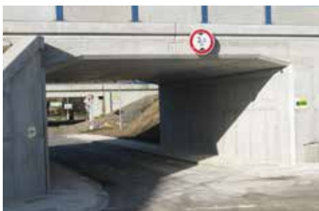
■ Železniční podjezd po ukončení stavby
