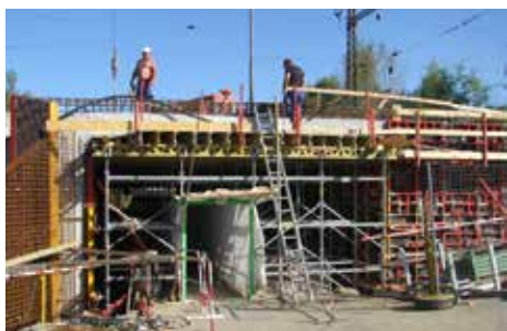
■ Železniční podjezd během stavby
