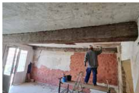
■ V přízemí budovy U Jelena začaly stavební práce na novém Infocentrum.
