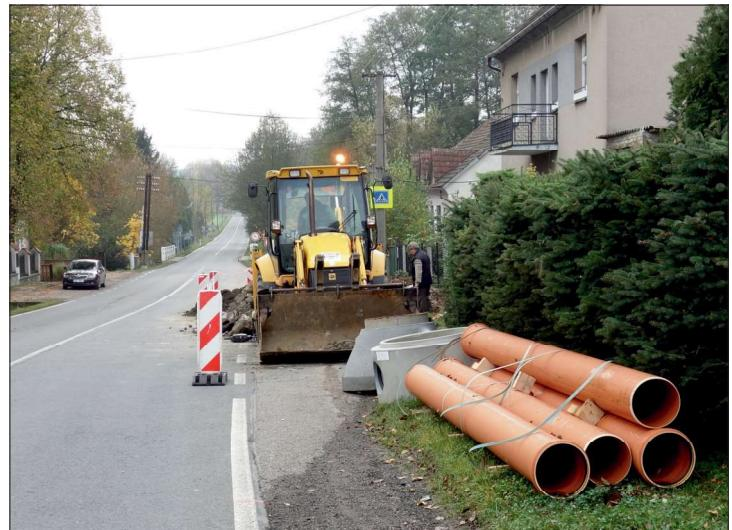
V Jarkovicích v říjnu probíhala rekonstrukce kanalizace. Práci komplikovala přítomnost telefonních kabelů a velkou část výkopu bylo z toho důvodu nutné vykopat ručně.
