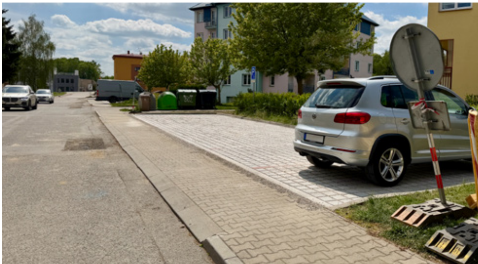
■ Povrchy parkovacích stání v ulici Nová se postupně obměňují. Parkování je vždy umožněno hned po dokončení parkovacího bloku.
